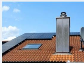
Durch Austausch der Module konnte bei gleicher Anzahl und Anordnung die Leistung nahezu verdoppelt werden.
