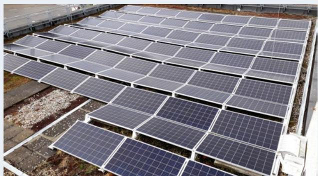
Eine kleinere Anlage mit wenigen, einzeln aufgeständerten Modulen wurde nach 14 Jahren erweitert, um die gesamte Dachfläche zu nutzen.
