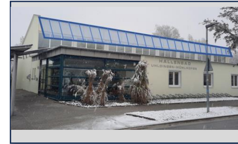
Bifaciale PV- Module vor der Fensterreihe des Hallenbades. – schematisch
