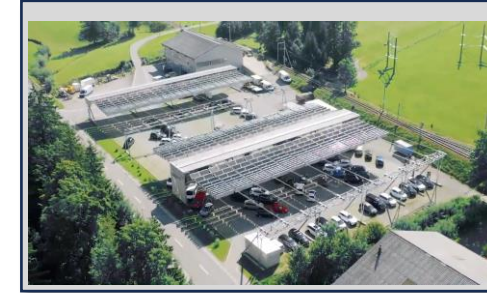
Faltbare PV- Anlage über Parkplatz. Quelle: Horizon
