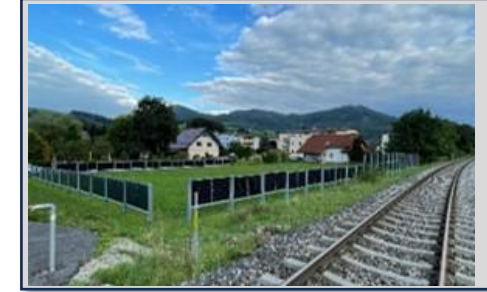
Solarzaun an einer Bahnlinie Quelle: Next2Sun Mounting Systems GmbH
